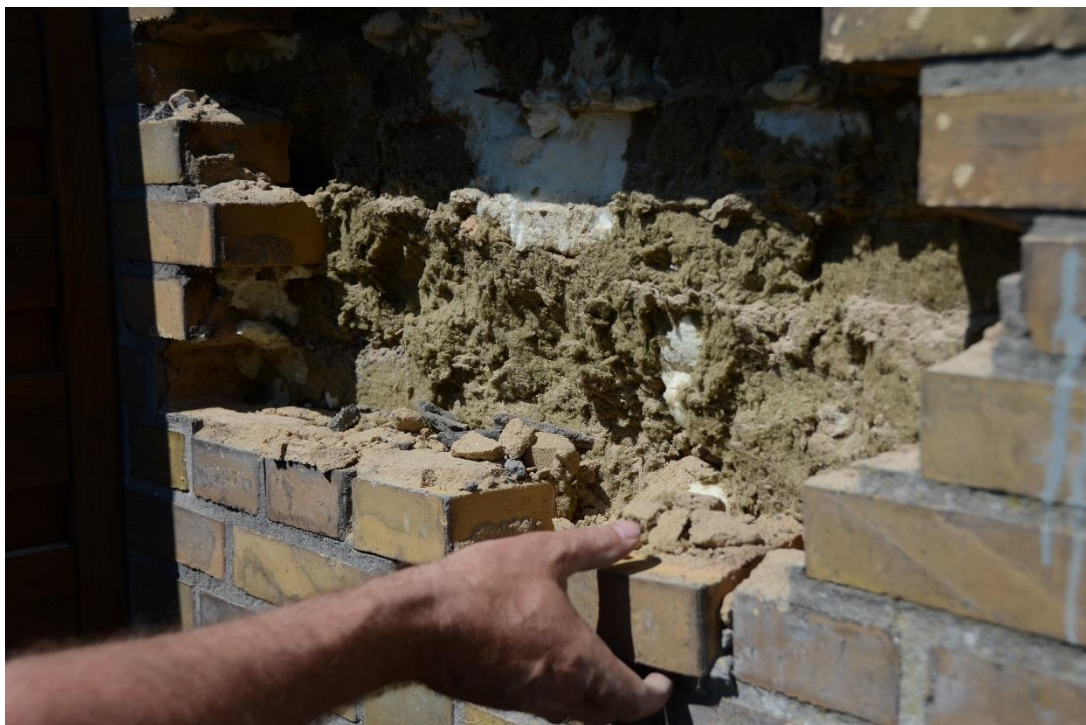
Fig. 6: Destruktive undersøgelser for at klarlægge tilstand og konstruktionsdetaljer
