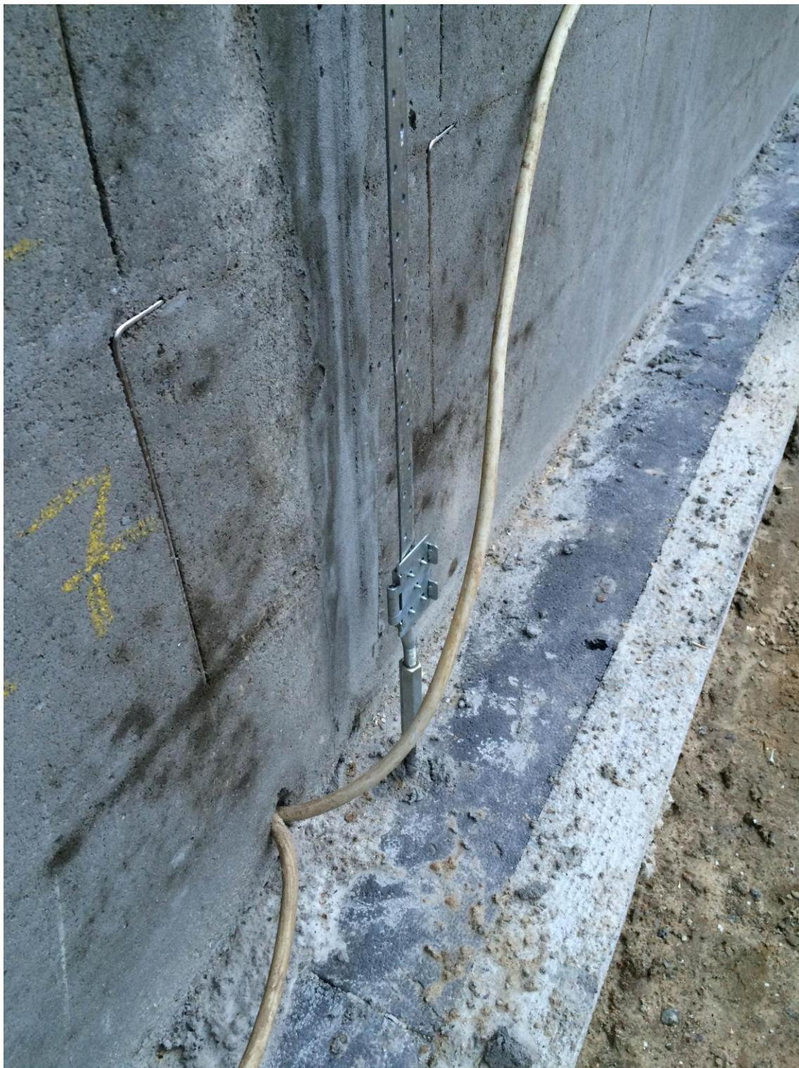
Figur 2.3. Opspændingsmekanisme til bånd
