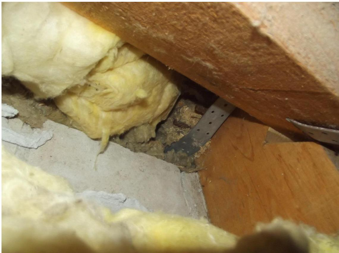
Figur 2.4. Forankringsbånd undergår en utilsigtet drejning
