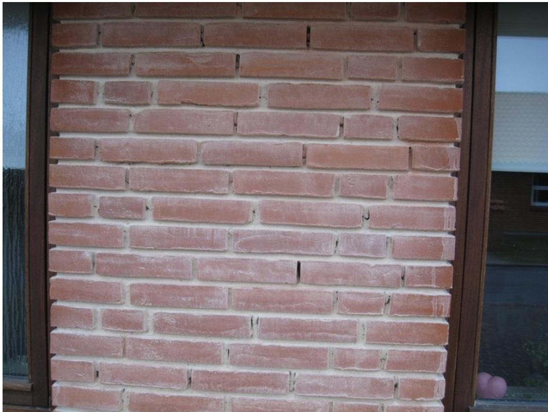
Figur 7.3. Efter 15 mm udkradsning af mørtefugerne ses gennemgående huller i dette murværk, der ikke er muret med "slåede studser over hele kopenden".
